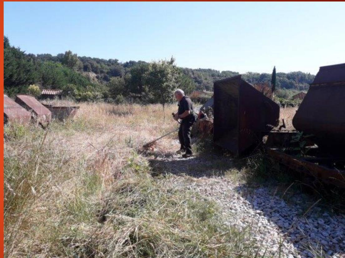
Pour pouvoir bouger le matériel en voie de 0,60 m, il faut au préalable tailler les herbes hautes pour dégager les voies et ensuite les prolonger avec des éléments portables
