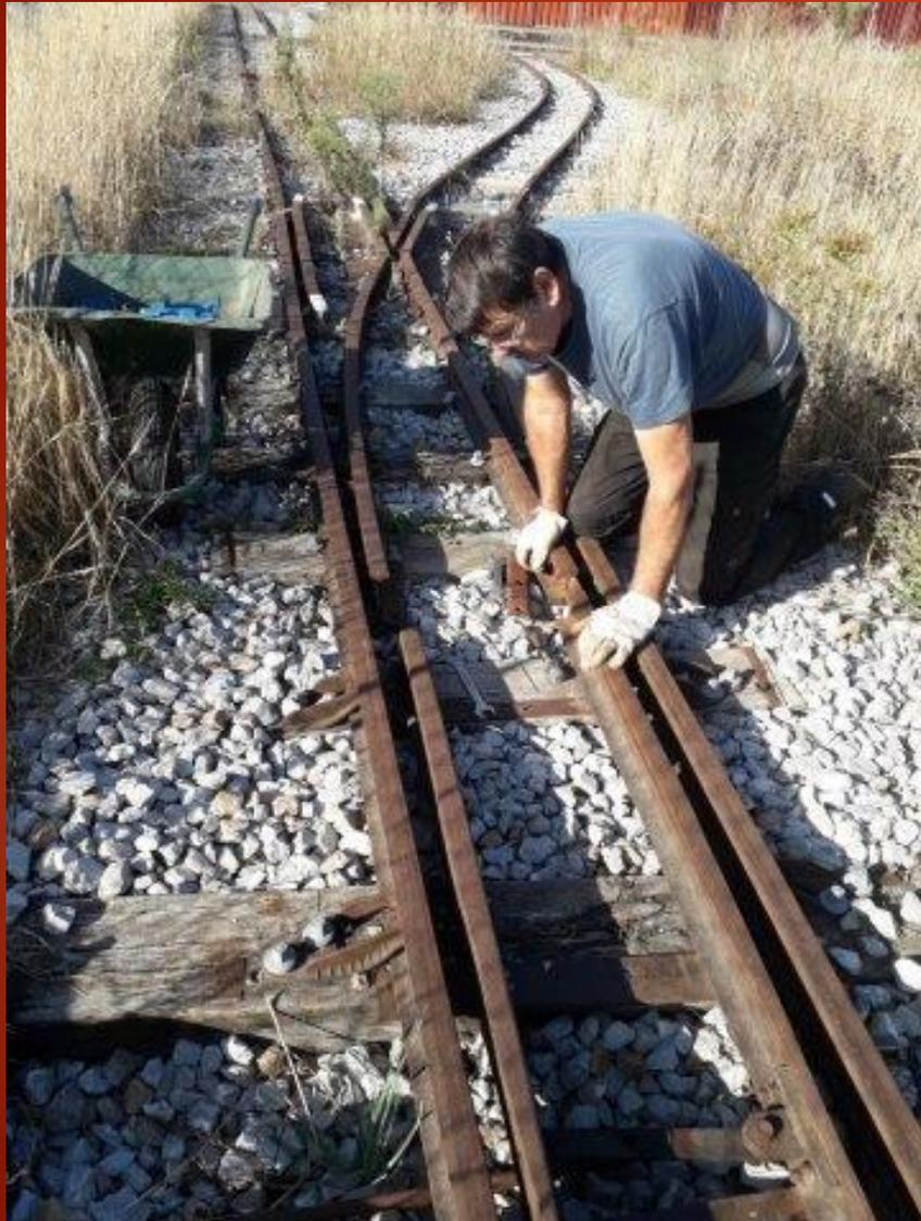
Les lames de cet aiguillage et la commande avaient été endommagées par un passage intempestif du tracto pelle. Réparation effectuée le 27 août.
