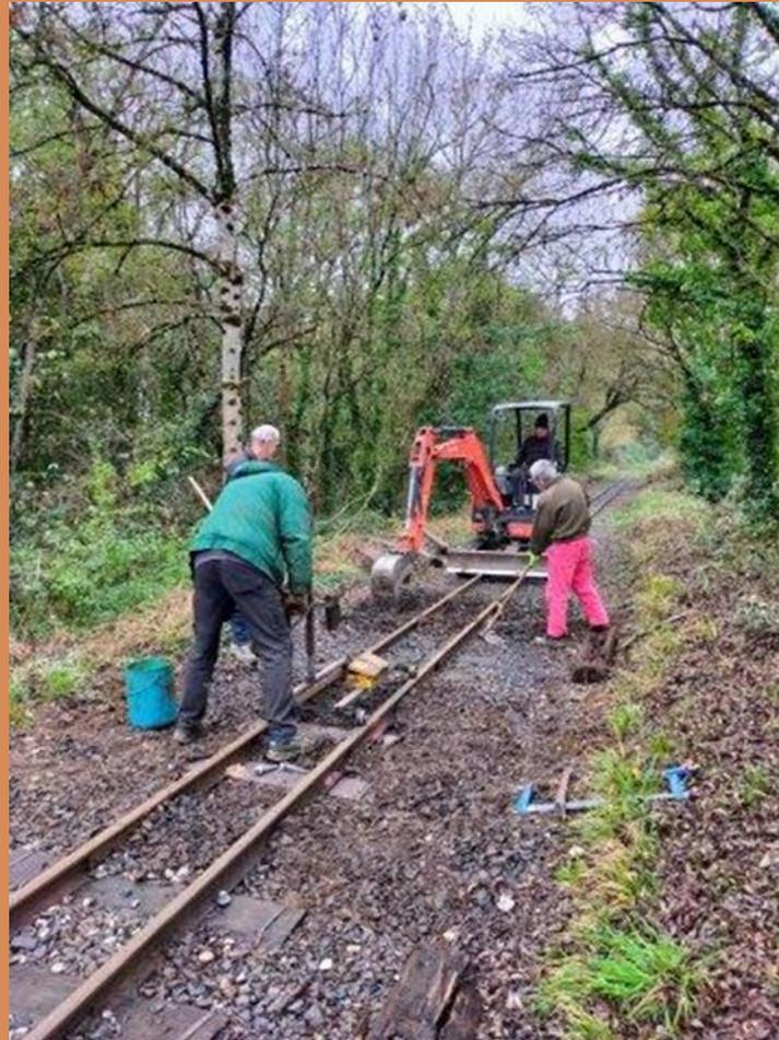
*Enlèvement des vieilles traverses, perçage des nouvelles et tirefonnage dans la foulée*
