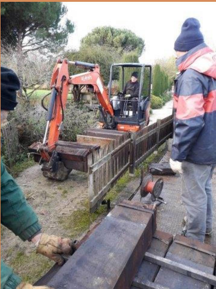
Les traverses neuves sont transportées sur le chantier par la mini-pelle
