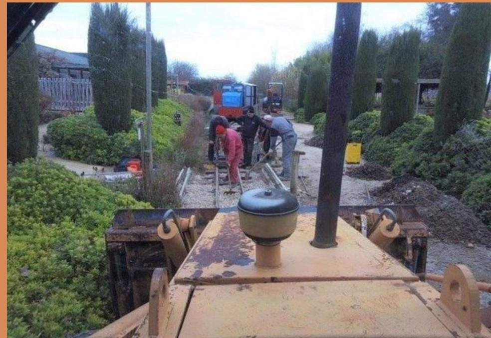
Complément de ballast amené du stock hors ligne (1,8 km par la route) par le tractopelle godet par godet
